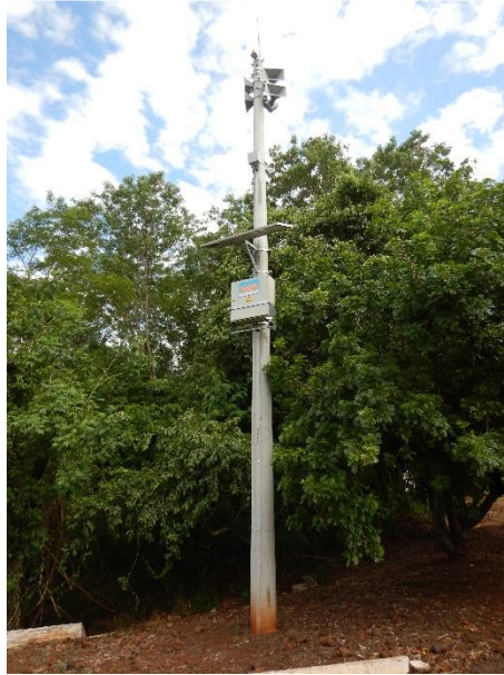
Figura 4: Estação Remota instalada na área interna da UHE Igarapava – margem esquerda Fonte: Arquivo Técnico da UHE Igarapava
