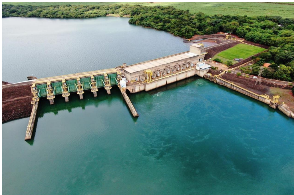
Foto 2: Vista dos extravasores e casa de força da UHE Igarapava
