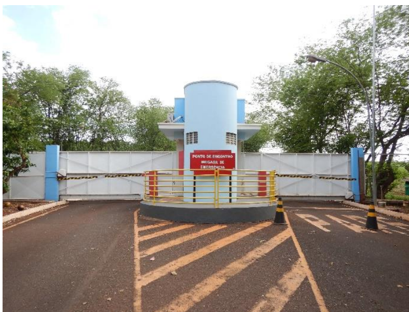
Figura 3: Pontos de Encontro 1 e 2 da UHE Igarapava Fonte: Arquivo Técnico da UHE Igarapava
